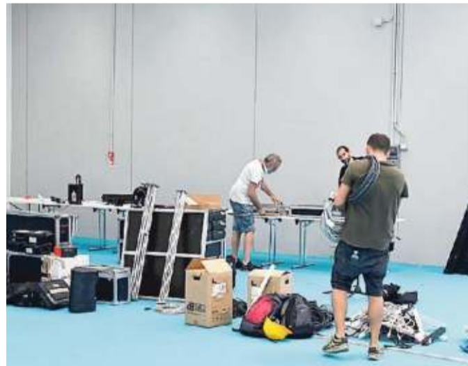
Le operazioni di smontaggio degli impianti ieri in Porto vecchio. Bruni
